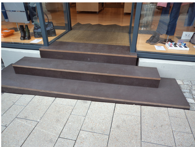
Hochbrücktorstraße 30: Pächter informiert darüber, dass er keine Genehmigung für eine Rampe erhalten hat. Rampe wäre jedoch mindestens als Kompromiss realisierbar.
