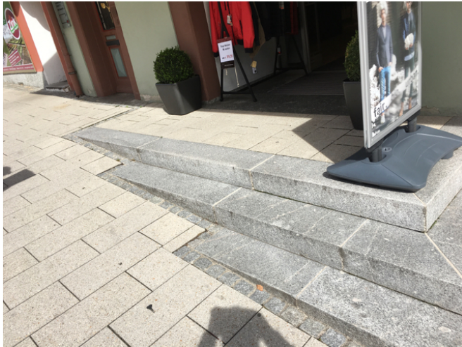
Nicht markierte Stolperfalle Hochbrücktorstraße 23. Der Blumenkübel erschwert die Nutzung der Rampe.
