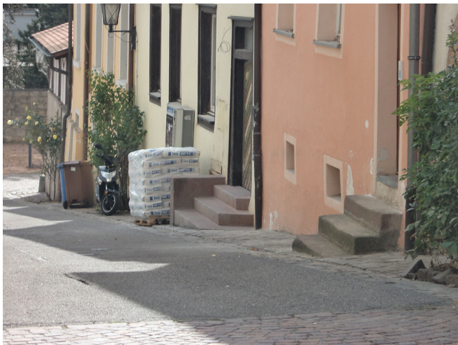
Kreuzung Sprengergasse/Suppengasse: mögliche Stolperfalle zwischen Teer und Pflaster.
