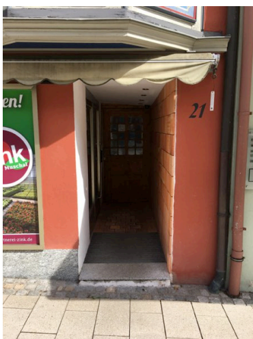
Mit wenig Aufwand barrierefrei gestaltbar (Hochbrücktorstraße 21). Optimal möglich bei Nutzungswechsel.
