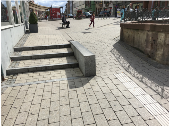
Zu steile Rampe am Marktbrunnen, die Stufen sind nicht markiert.
