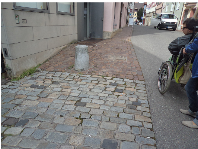
Unterschiedliche Arten von Kopfsteinpflaster: Die größeren Pflastersteine sind gröber und deswegen schlechter befahrbar.
