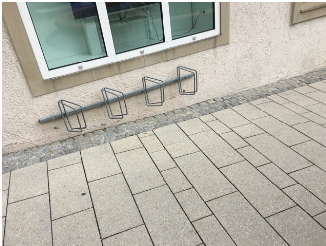
Durch den Fahrradständer an dieser Stelle wird der Durchgang zu eng.
