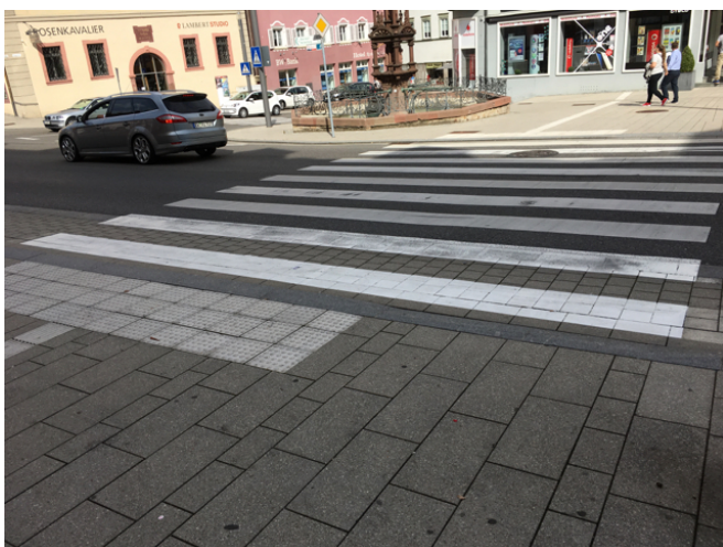
Gute Lösung am Zebrastreifen Hochbrücktorstraße: Markierung und kleiner Bordstein für Sehbehinderte. Der Übergang für Rollstühle und Kinderwagen ist abgeflacht.
